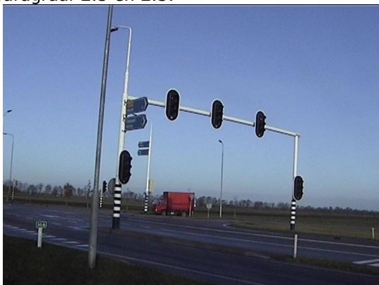
TLP bestaande uit TLE + ligger + VRI mast
